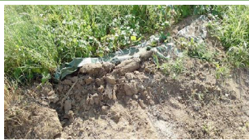
Barrière anti-batraciens disparue avec les travaux pendant plusieurs mois...
